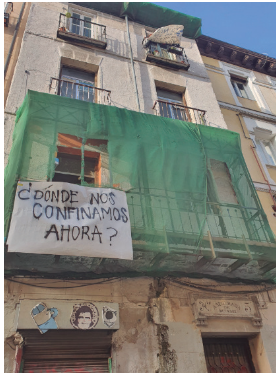
Figura 2. Edificio con fachada protegida ocupado ilegalmente en el barrio de Lavapiés. Fuente: F.J. Rufián 03/04/21.
