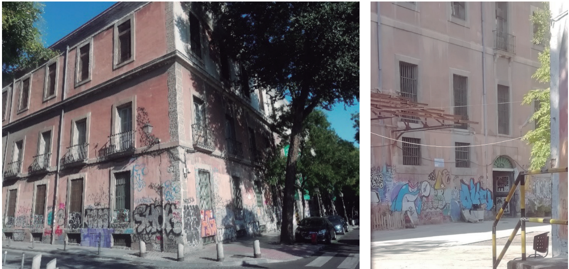
Figura 3. Estado del Edificio de Tabacalera, en el barrio de Embajadores de Madrid. En parte dedicado a actividades culturales y en parte cedido a asociaciones. En este caso es propiedad de una administración pública. Fuente: F.J. Rufián 03/04/21.
