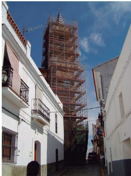
Figura 19. Vistas del proceso de obras en la Iglesia de la Asunción (Foto: N. Medina).
