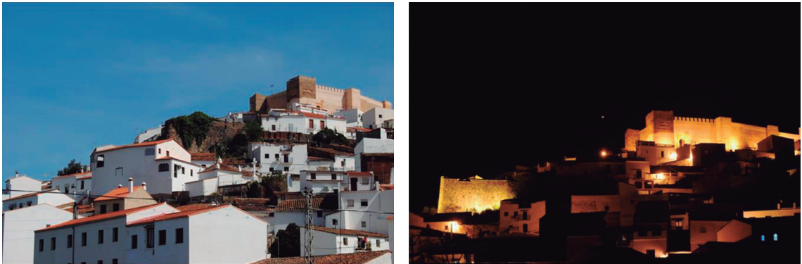
Figura 10. Antes y después del Baluarte de Calle Cota (Fotos: N. Medina).
