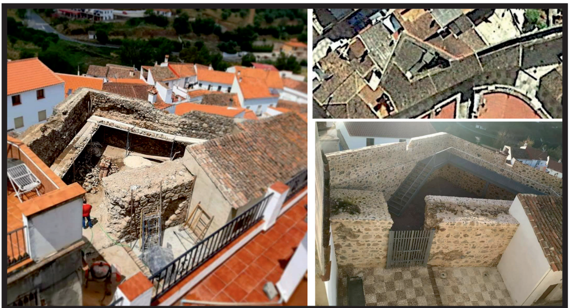
Figura 11. Proceso de recuperación del Baluarte de Calle Portillo (Fotos: N. Medina).
