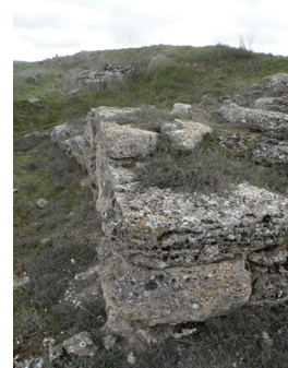
Figura 10. Aspecto actual de la esquina de la entrada norte.
