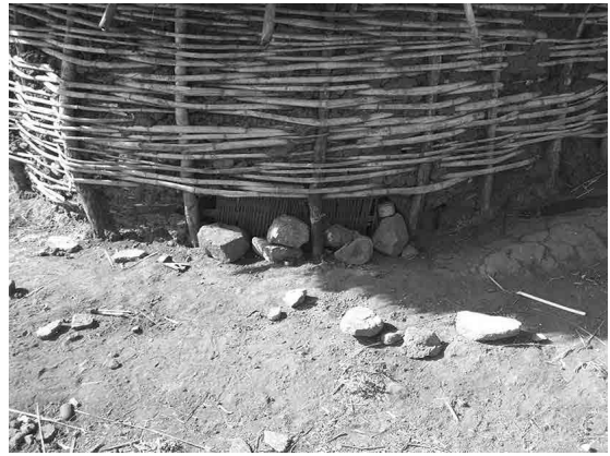
Figura 3. Detalle de los orificios u “órgano excretor” de la casa bertha, Obora (Menge wereda). Fotografía del autor.
