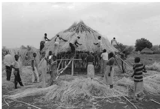
Figura 15. Hombres gumuz poniendo el tejado de una casa en construcción, con la colaboración de las mujeres (Mahal Gerara, Mahadid, Qwara). Fotografía del autor.
