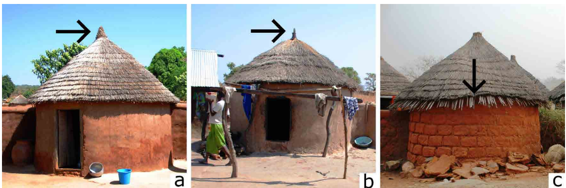
Figura 8. Techos tradicionales de las habitaciones. a- Mamprusi (Casa Dama, en Bende); b- Komba (Casa Jijirs, en Nasua Tambí); c- B'moba (Casa indeterminada, Nanjong I).
