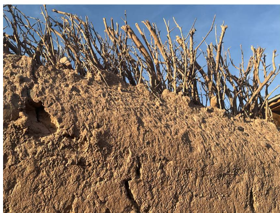
Figura 24a. Imagen de un muro de tapial en San Pedro de Atacama (Chile) con remate superior en forma triangular para facilitar la evacuación del agua y reducir la erosión de la lluvia. Foto: A. Mederos.
