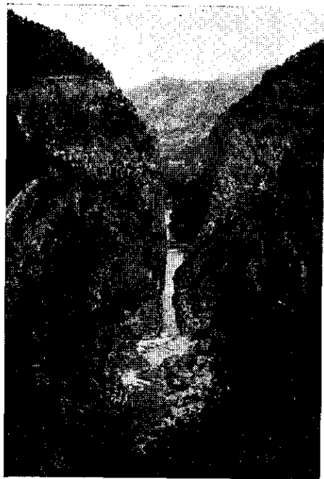
Foto n.º 6.— Vista de la cerrada de la solución I, desde aguas abajo.
