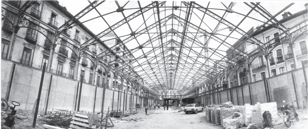
Figura 8A. Estructura metálica del Mercado del Val durante su restauración [1982], 1981. (Cacho, AMVa, MCO 00306-003)
