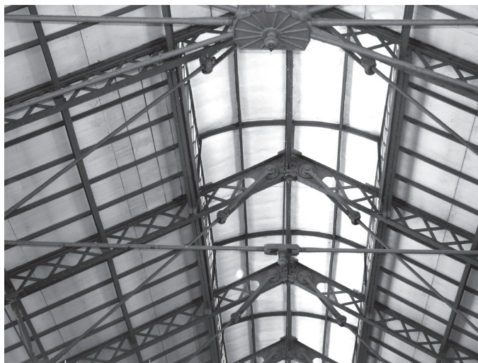
Figura 7. Detalle de los cuchillos del Mercado del Val, antes de la restauración concluida en 2016. (Fotografía del autor)
