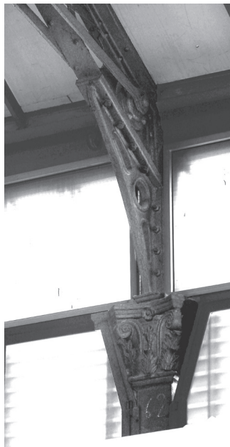
Figura 6. Detalle de capitel y ménsula, antes de la restauración concluida en 2016. (Fotografía del autor)
