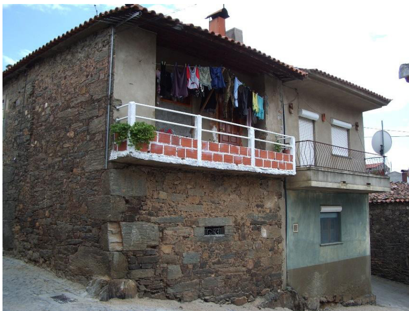
Fig. 7. Intervención en un corredor de una casa de Poiares (Portugal). Fotografía del autor.
