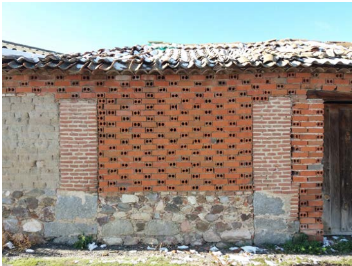
Fig. 6. Distintos aparejos preindustriales e industriales en una construcción en Santo Domingo de las Posadas (Ávila, España). Fotografía del autor.
