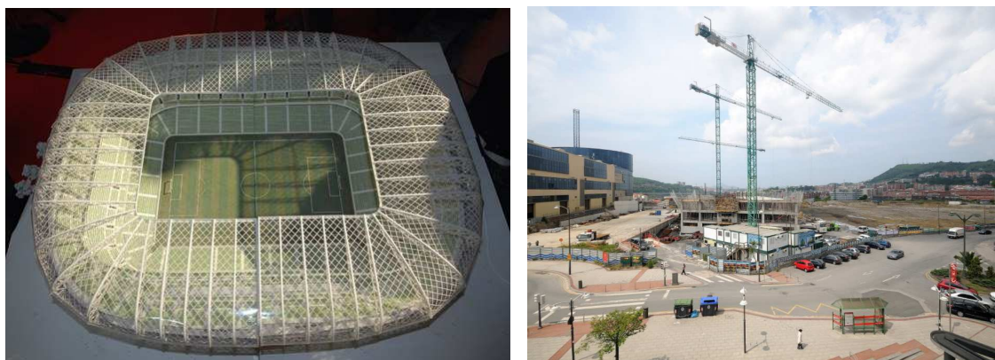
Figura 16. Proyecto y obras del nuevo estadio de San Mamés.
