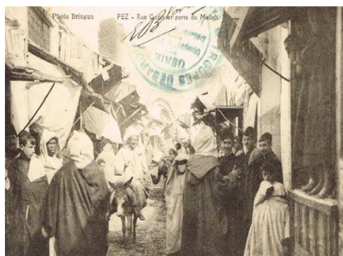
Fig. 4. Rue Gadia et porte du mellah, Fès. Bríngau, 1919. CCJM, nº 24283.
