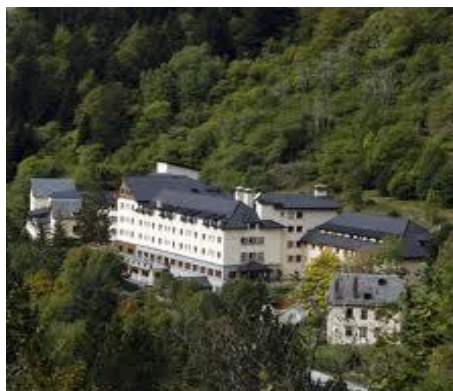
Figura 3 – Balneario de Caldes de Boí
