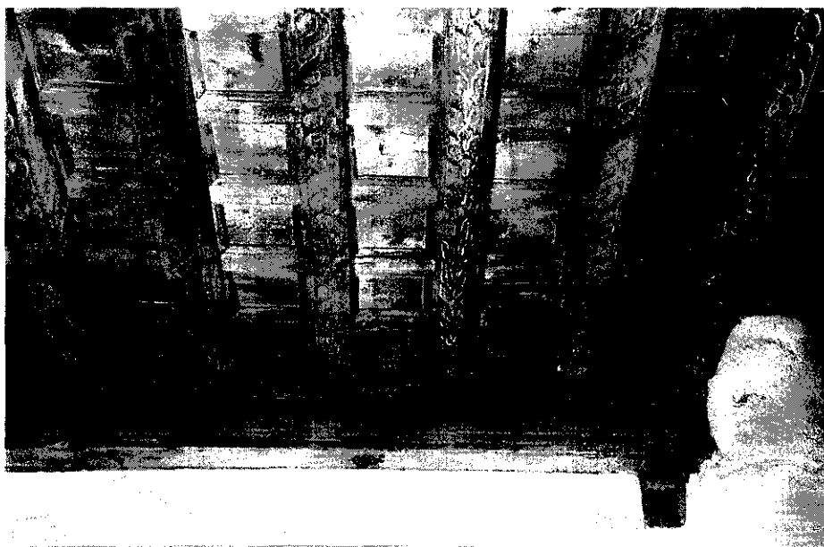
Fig. 12.— Iglesia de San Pedro de Camarma de Esteruelas (Madrid). Alfarje de la tribuna. Detalle de jácenas, solera y ménsula.
