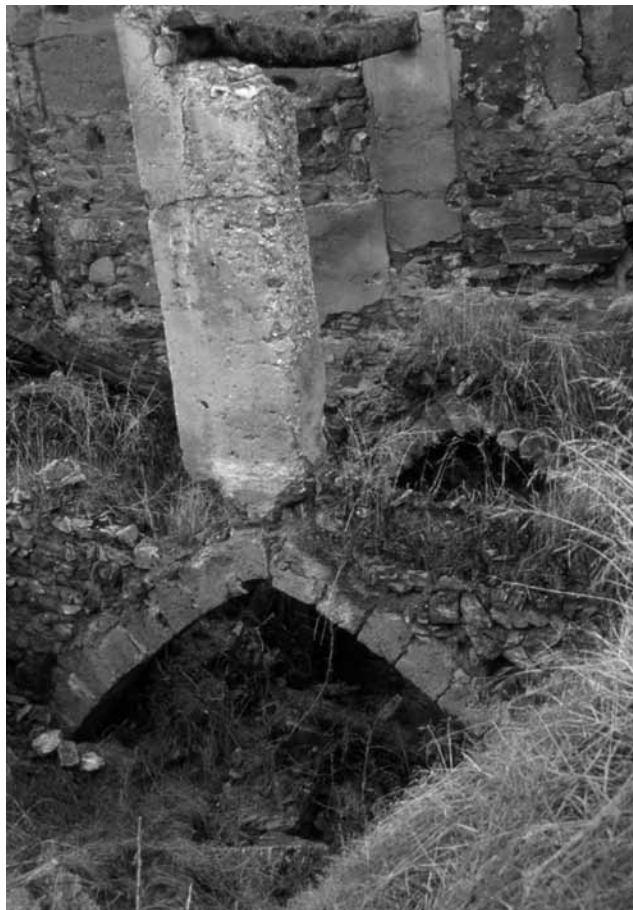
Fig. 1. Granja de Zaragocilla, s. XIII-XIV, detalle de los arcos diafragma apuntados de una sala de planta rectangular.
