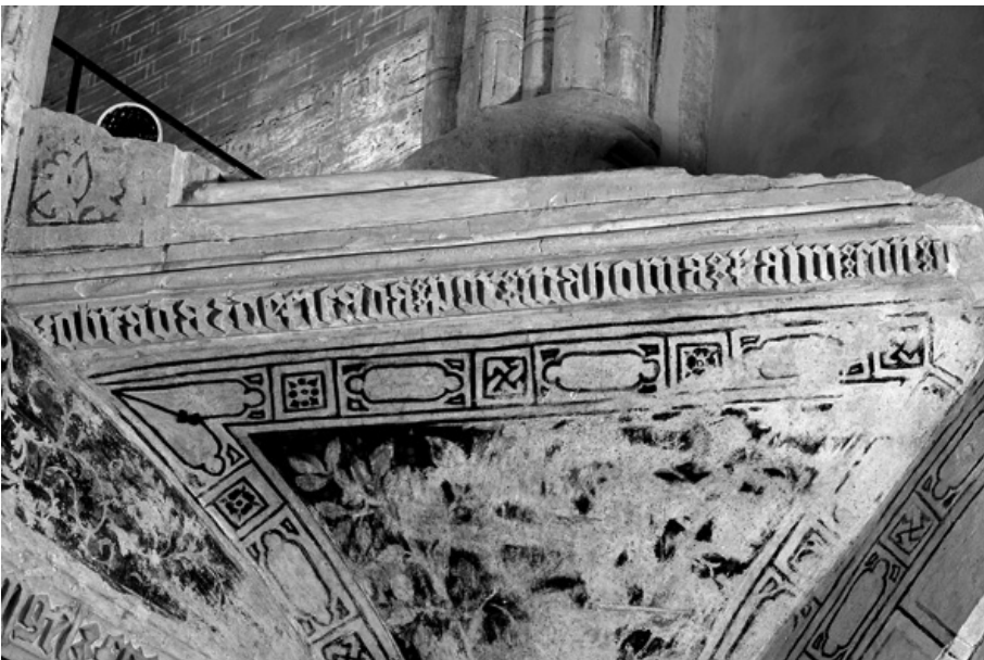
Fig. 4. Inscripción tallada en yeso, con la leyenda "/>obra/ deficada/ por/ mahoma/ rami/ con/ [dios]/". Coro alto. Iglesia de Santa Tecla en Cervera de la Cañada (Zaragoza). Obra acabada por el maestro moro Mahoma Rami en el año 1426.
