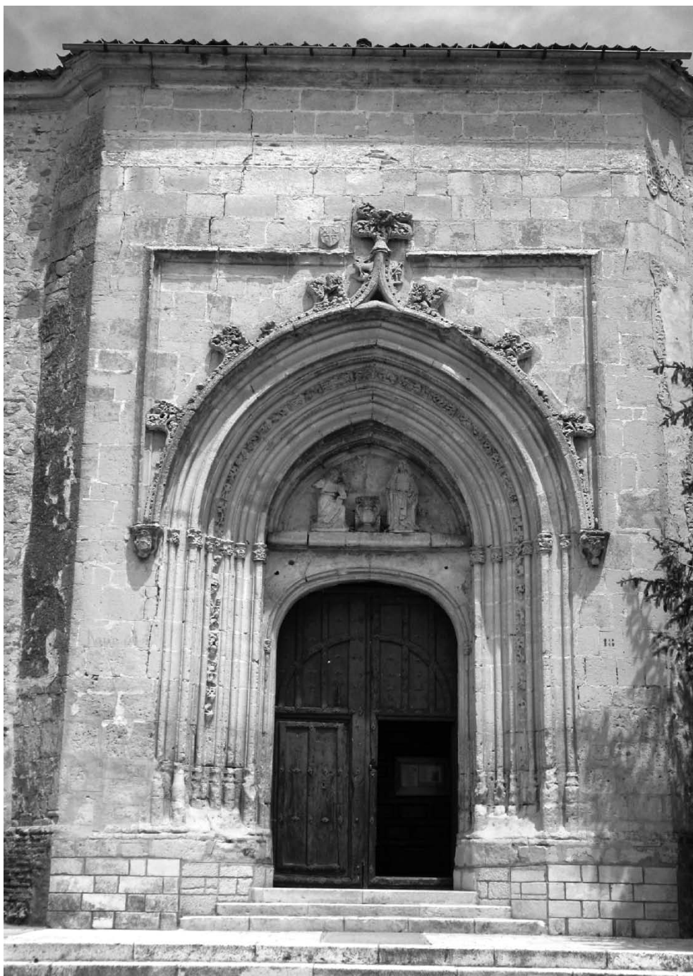
Lamina 1. Fachada meridional de la iglesia de Santa María.
