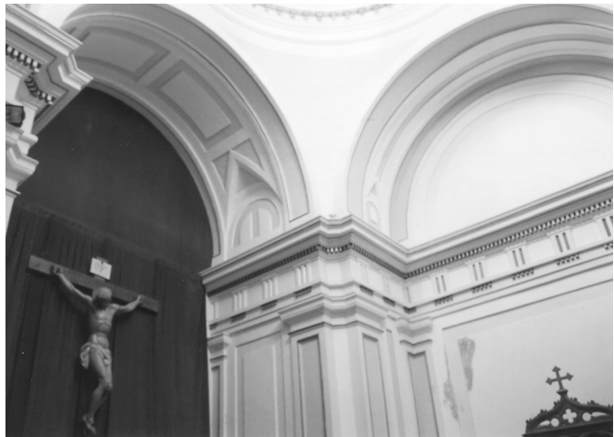
Lám. 4. Capilla. Interior.
