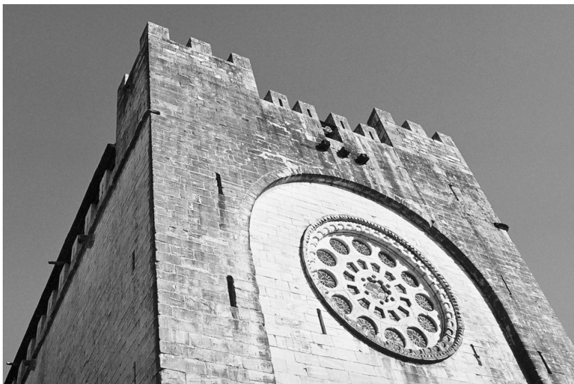
Fig. 5.- Detalle de la fachada de San Juan de Portomarín (Lugo). Finales s. XII-principios s. XIII. Torreones, almenas, merlones y antigua ladrónera.
