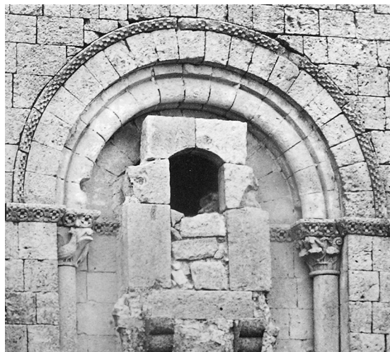
Fig. 2.- Ménsulas de apoyo de un antiguo puente levadizo o pasarela en la iglesia románica del castillo de Turégano (Segovia).
