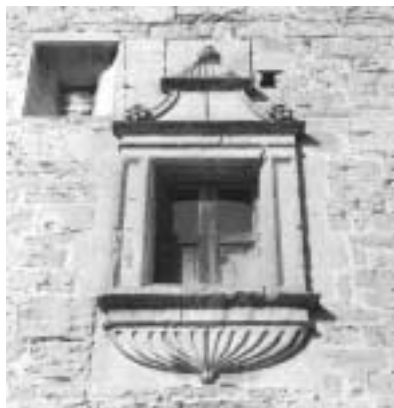
Foto 12. Fachada sur, detalle. Vano.
