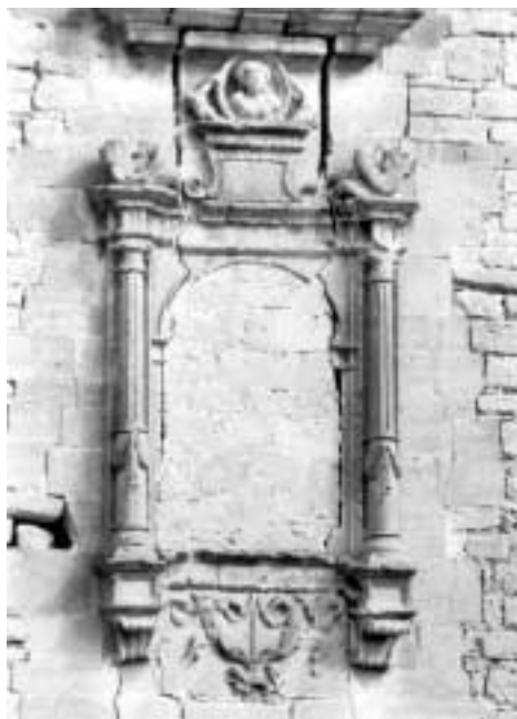
Foto 7. Torre de la fachada oeste, detalle. Vano inferior.
