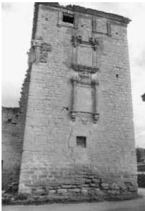
Foto 5. Fachada Oeste. Vista de la torre.
