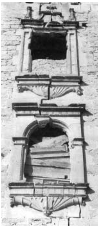
Foto 10. Fachada sur, detalle. Vanos de la torre suroeste.
