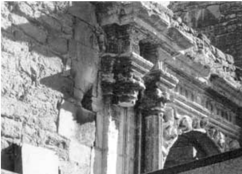
Foto 3. Fachada Oeste, detalle. Vano de acceso principal a la Casa Solariega Las Torres.
