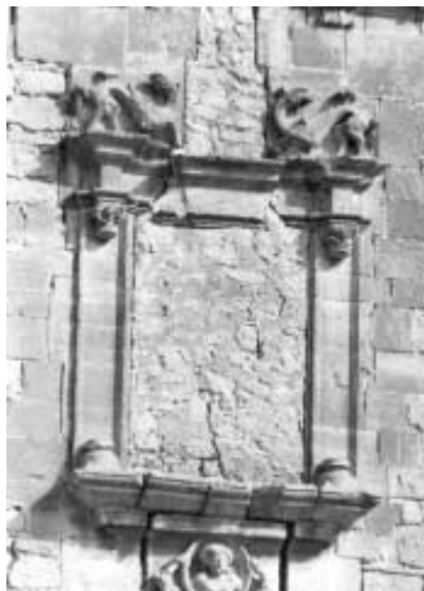
Foto 8. Torre de la fachada oeste, detalle. Vano superior.
