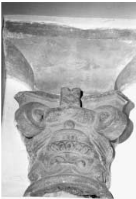
Fig. 13. Monasterio de las Descalzas Reales. Patio, galerías bajas. Capitel 19-O.
