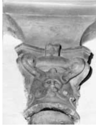
Fig. 22. Monasterio de las Descalzas Reales. Galerías bajas. Capitel de volutas inversas (11-S).
