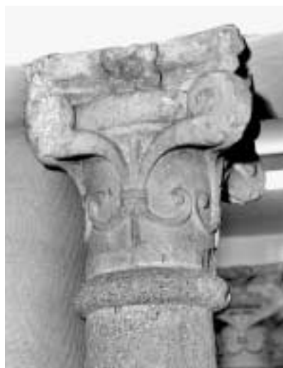
Fig. 20. Monasterio de las Descalzas Reales. Capitel de la Sala de columnas junto a la escalera.
