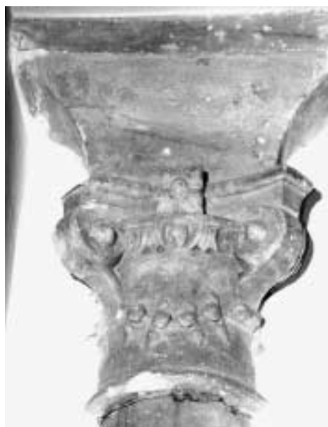
Fig. 10. Monasterio de las Descalzas Reales. Patio, galerías bajas. Capitel de volutas amensuladas (6-E).
