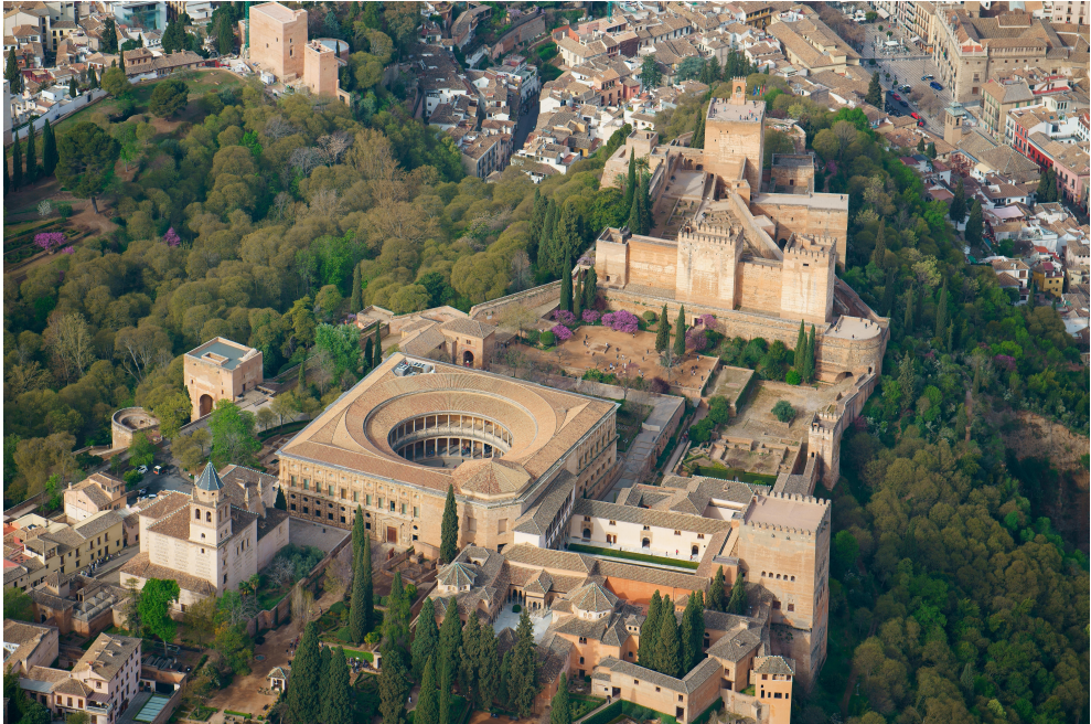
Figura 5. Vista aérea de la Alhambra de Granada Figura 4. Fotografía: Alamy
