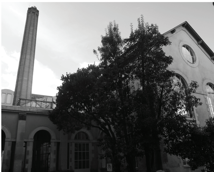
Fig. 6. Estado actual de la biblioteca. Fuente: Elaboración propia, enero de 2016.
