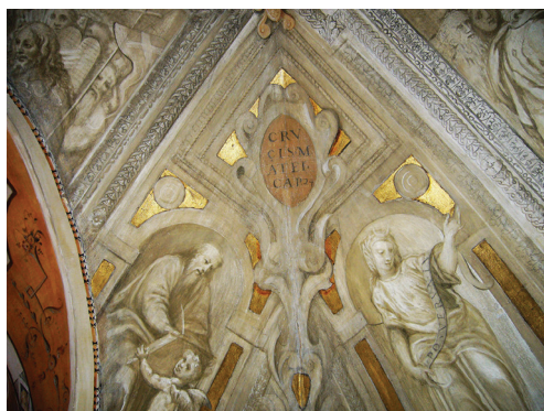
Fig. 11. Monasterio de las Descalzas Reales, Madrid. Capilla del Cristo: bóveda, detalle arista.
