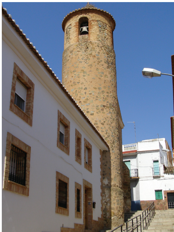
Fig. 1. Torre de la iglesia de Santa Quiteria. Fuente del Fresno.
