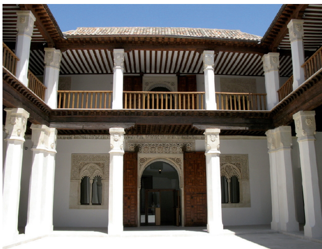
Fig. 4. Palacio de Fuensalida: patio alto, portal y corredores.
