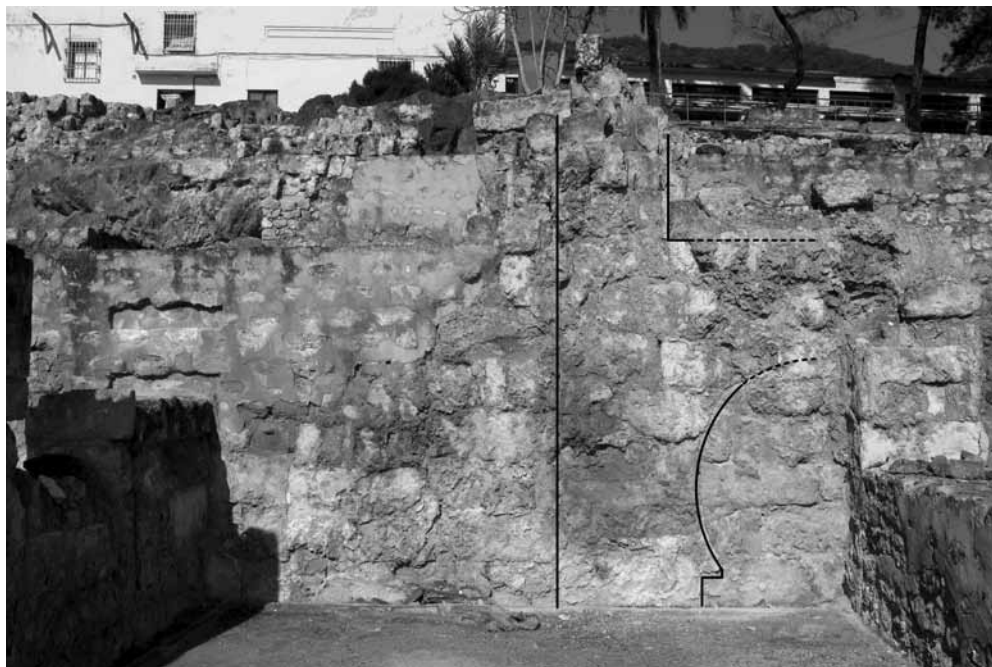
Fig. 6. Arco condenado y adosamiento en paramento de las estancias orientales. Baño.
