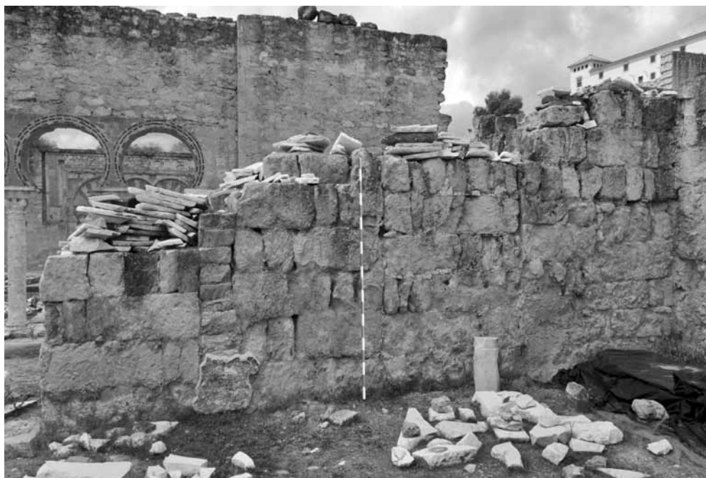
Fig. 10. Muro con adosamientos en las salas orientales de la Vivienda de la Alberca.
