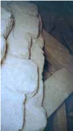
Fig. 9. Bóveda central de la macsura: trasdós de su cúpula central apoyada sobre vigas de madera.
