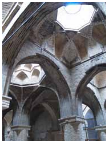
Fig. 12. Mezquita de Ispahán (Irán): bóvedas de la sala de oración.
