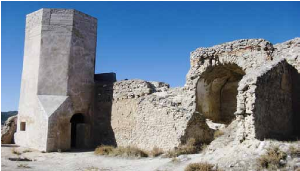
Fig. 3. Torre de sección octogonal y plaza de armas con aljibe del Castillo Mayor de Calatayud, s. IX.
