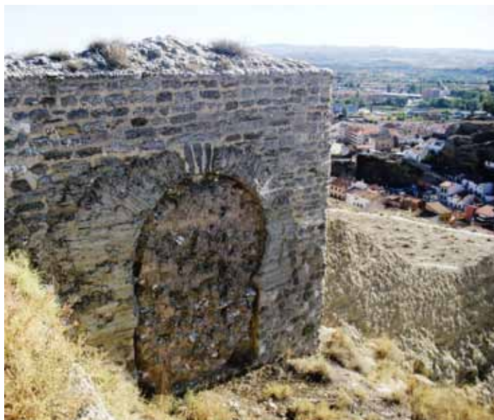
Fig. 4. Puerta en arco de herradura emiral, abierta en el sector norte de la muralla de Calatayud, s. IX.
