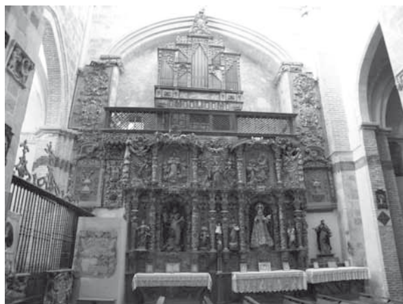
Fig. 2. Convento de Santa María la Real de Nieva, interior de la iglesia, tribuna.
