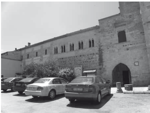
Fig. 1. Convento de Santa María la Real de Nieva, entrada al Palacio Real.
