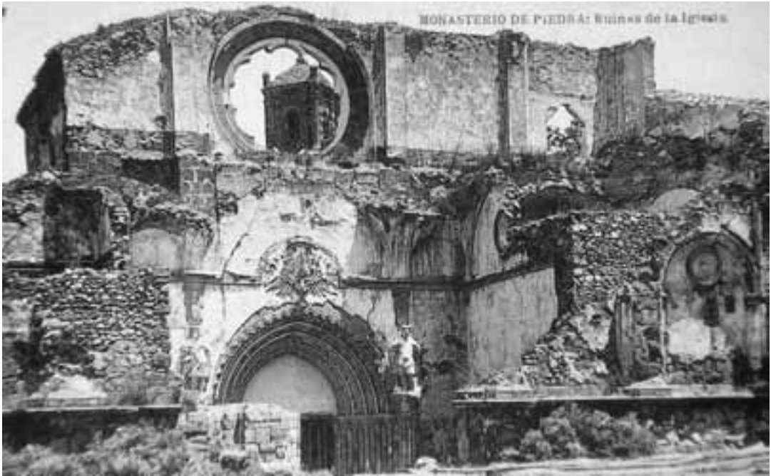
Fig. 6. Postal impresa a partir de una fotografía de Hauser y Menet que muestra el estado de la puerta occidental de la iglesia abacial del Monasterio de Piedra a finales del XIX.
