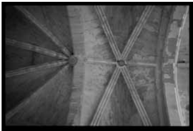
Fig. 4. Cubriciones abovedadas con nervadura en ligazón central del presbiterio y ábside de la iglesia abacial de Santa María de Piedra.
