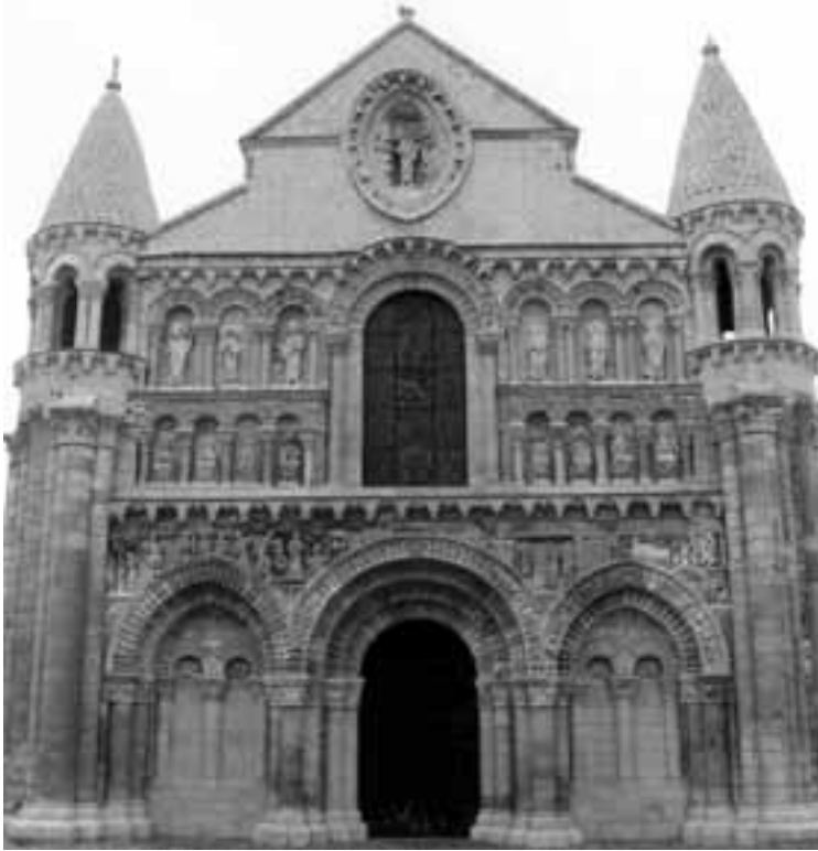
Fig. 2. Notre-Dame-la-Grande de Poitiers. Fachada oeste (foto: autor).
