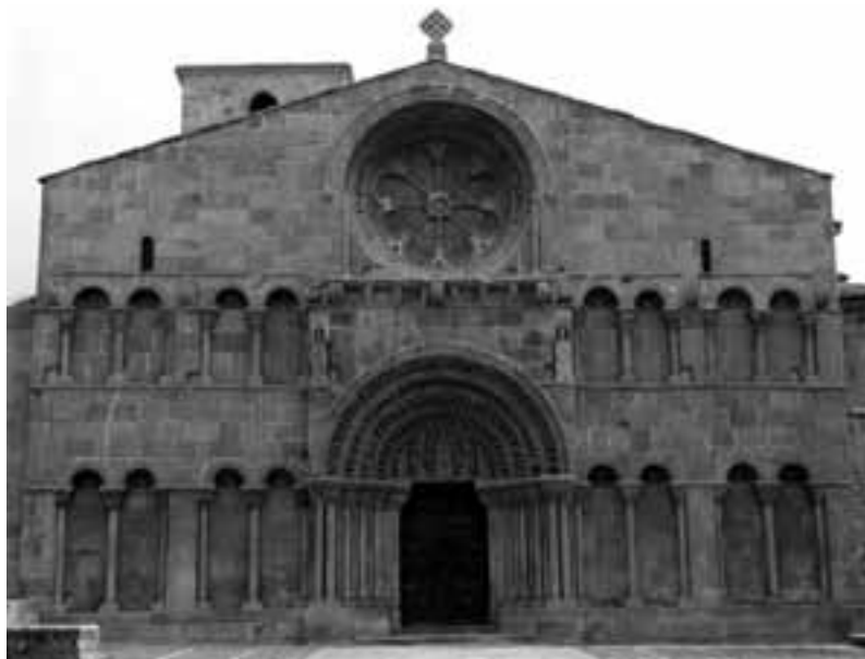
Fig. 1. Santo Domingo de Soria. Fachada oeste (foto: autor).
