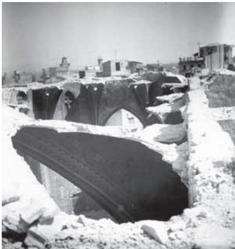
Fig. 4. Bóvedas de crucería con plementos tabicados fotografiados durante su demolición en 1937 de la iglesia de santa María de Castellón de la Plana.
