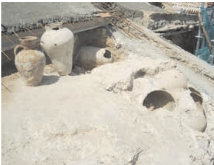
Fig. 6. Trasdós de una bóveda de crucería del siglo XIV, aligerada con vasijas cerámicas en Villafamés (Castellón).
