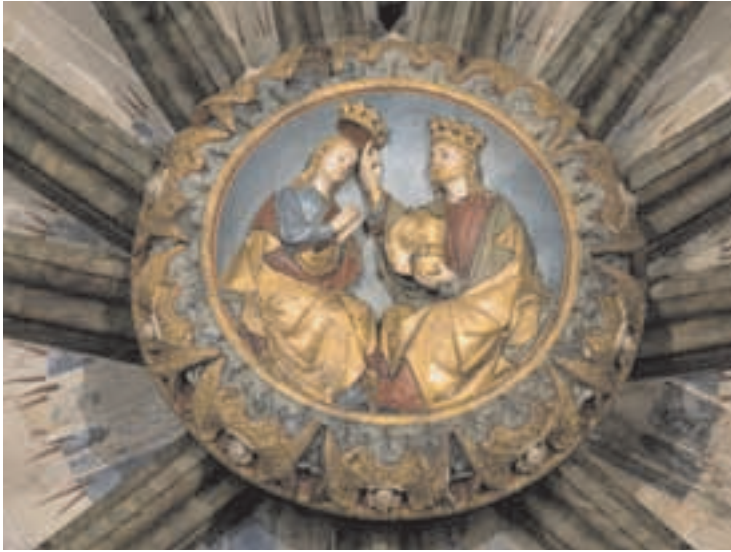
Fig. 7. Clave del ábside de la catedral de Tortosa (siglo XIV) de 2,60 metros de diámetro y más de seis toneladas de peso.
