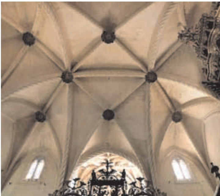
Fig. 11. Bóveda con arcos transversales del crucero de la catedral de Orihuela (Alicante). Fotografía de J. Bérchez.
