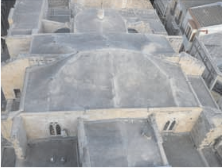
Fig. 12. Trasdós de la bóveda del cruceiro de la catedral de Orihuela (Alicante).
