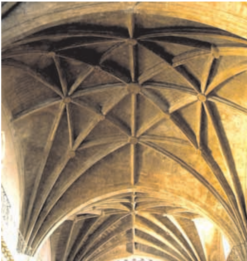
Fig. 15. Bóveda de crucería de rampante redondo de la iglesia de santa María de Onteniente (Valencia). Fines del siglo XV y comienzos del siglo XVI.
