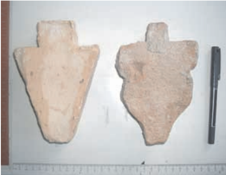
Fig. 3. Ladrillos aplantillados pertenecientes a los nervios de sendas bóvedas de crucería (con plementos tabicados), procedentes de las iglesias de Torreblanca y de la cartuja de Valdecristo, ambas de Castellón.
