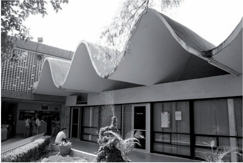
Fig. 4. Facultad de Contaduría Pública y Administración (FACPyA), Ciudad Universitaria de Monterrey. Cascarón de concreto alabeado que sirve de cubierta a la biblioteca de la Facultad
