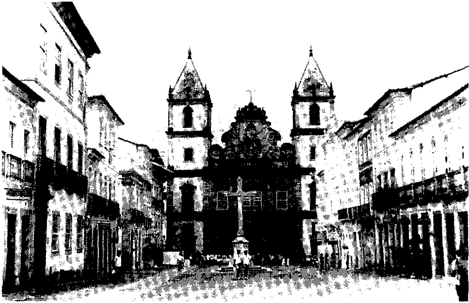
Iglesia del convento de San Francisco, al frente se encuentra la Cruz de Mármo (Terreiro de Jesus).
