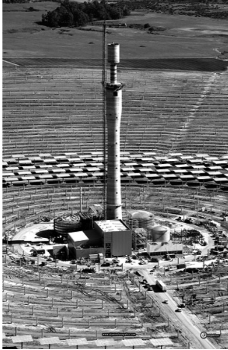
Figura 10. Central Gemasolar en construcción. Mayo 2010
