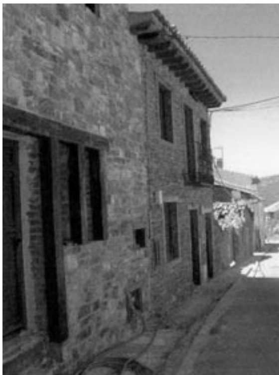
FIGURA 2 Casas rehabilitadas del Berrueco
