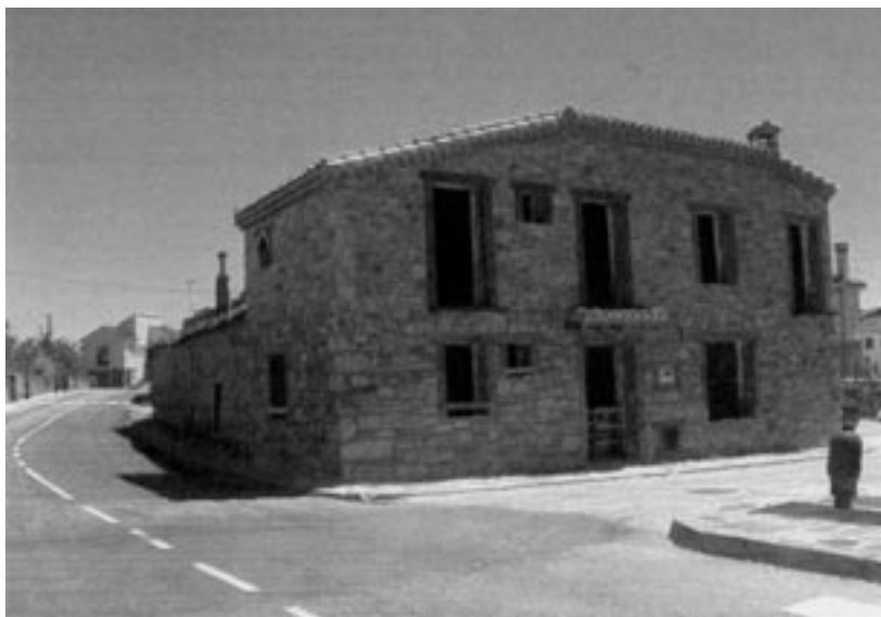
FIGURA 3 Rehabilitación de casas de El Padrón
