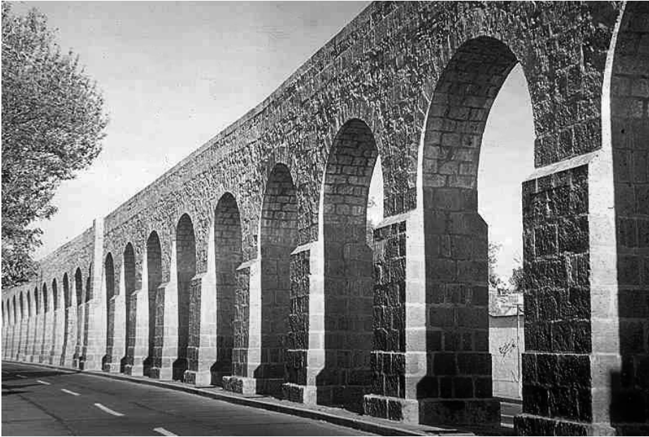
El acueducto, rehabilitado en 1997, se prolonga sobre dos kilómetros.
