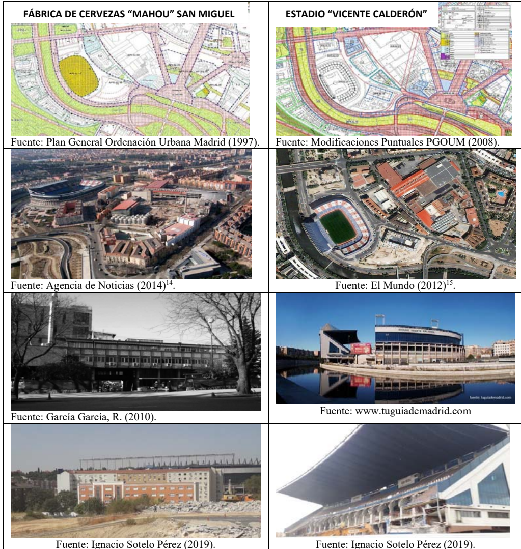
Figura 4. Evolución de la demolición-transformación del Complejo “Nuevo Mahou-Calderón”.
