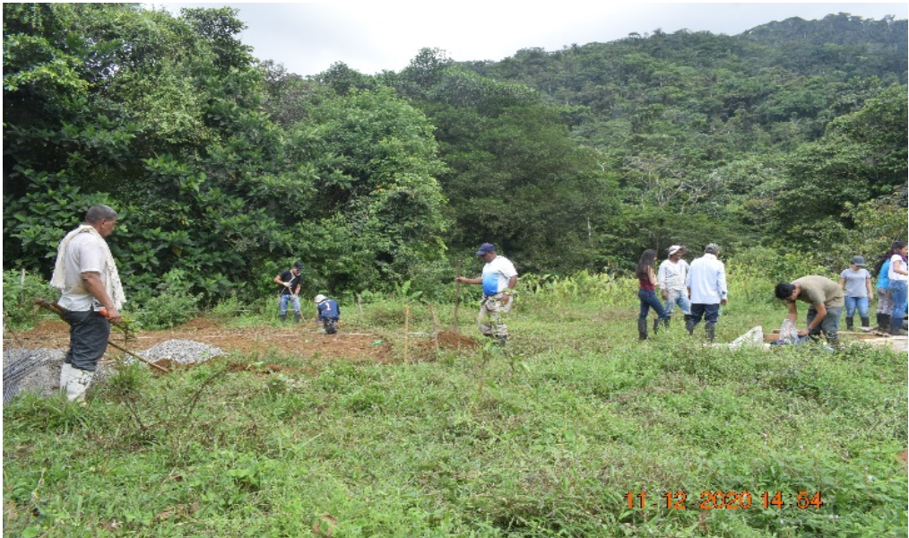
Figura 7. Portada, inicio de obra.
