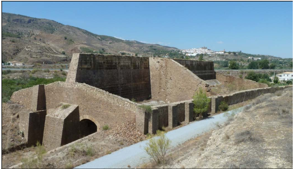
Figura 2. Cargadero de mineral de Los Canos, junto a la antigua vía del ferrocarril Guadix-Almendricos, hoy vía verde (Serón).
