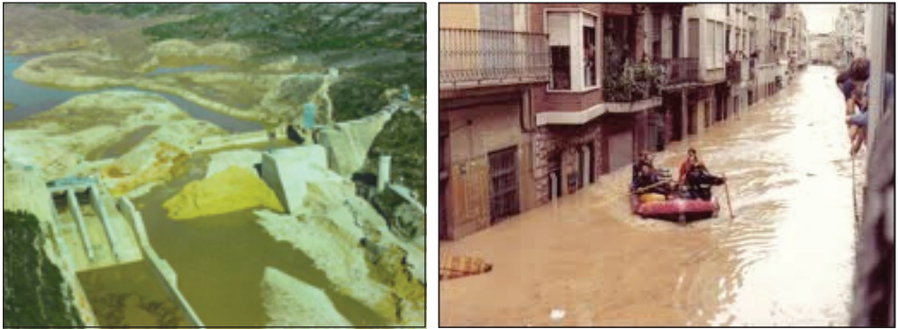
Figura 17. Efecto de la avenida del Júcar, en octubre de 1982. Rotura de la presa de Tous e inundaciones en la localidad de Alcira
