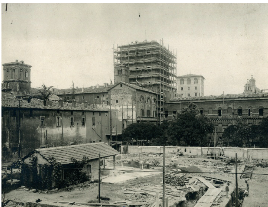
Fig. 8. Carlo Carboni, Palazzo Venezia, Lavori di demolizione , 1911 [maggio 3 agosto 1910], gelatina ai sali d'argento/ vetro, 24x31 cm. Roma, Gabinetto Fotografico Nazionale, Inv. C010780.
