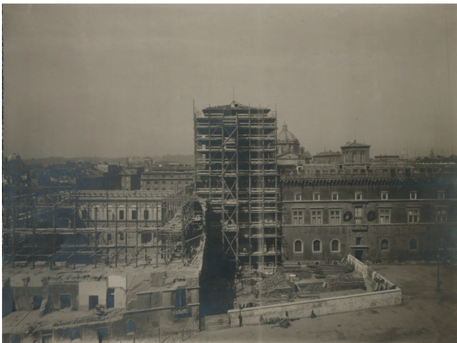
Fig. 7. Carlo Carboni [?]. Palazzetto Venezia, Lavori di demolizione , 3 agosto 1910. Vienna, AT-OeStA/HHStA, MdÄ, AR, F6, 94, f. 003.
