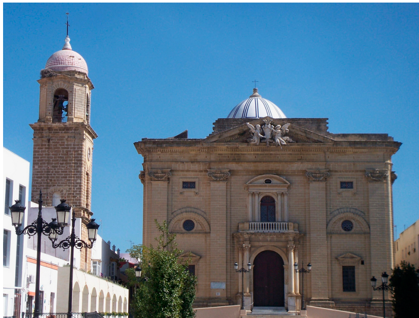
Torcuato Cayón y Torcuato José Benjumeda, Fachada de la Iglesia de San Juan Bautista. Chiclana de la Frontera. Estado actual.
