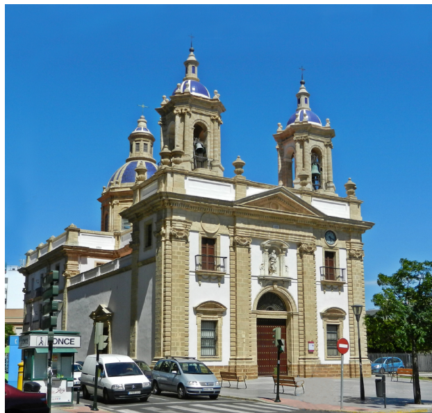
Torcuato Cayón y Torcuato José Benjumea, Fachada de la Iglesia de San José. Cádiz. Estado actual
