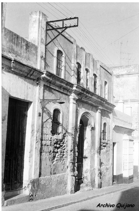
Torcuato Cayón y Torcuato José Benjumeda, Capilla de San Antonio. San Fernando. Estado de ruina antes de su demolición. Década de 1960. Fotografía Quijano.
