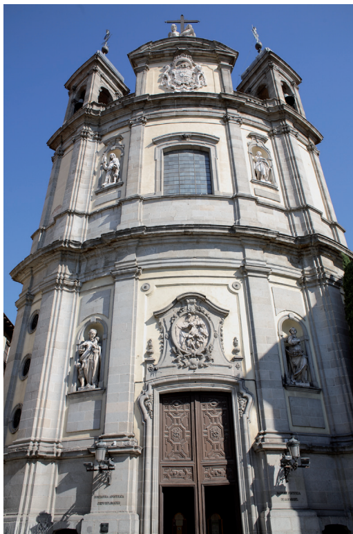
Fig. 2. Fachada de la iglesia madrileña de los santos Justo y Parsor.
