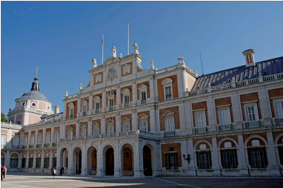
Fig. 4. Palacio Real de Aranjuez, fachada principal.
