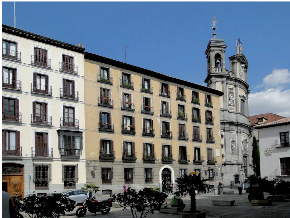
Fig. 3. Vista de la iglesia de los santos Justo y Pastor desde la Plaza del Cordón.
