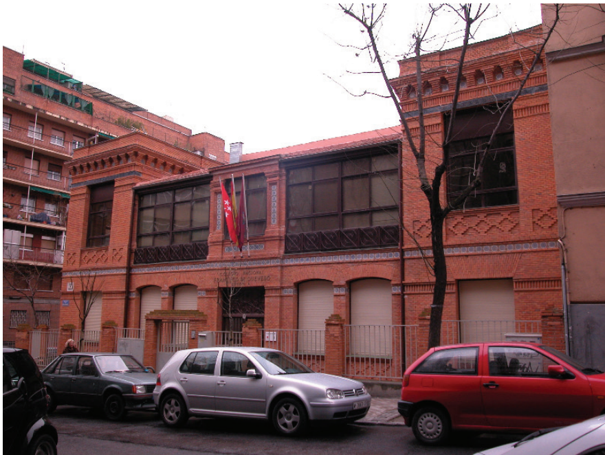
Fig. 8. Estado actual del edificio destinado a estudio fotográfico de la firma J. Laurent&Cia.
