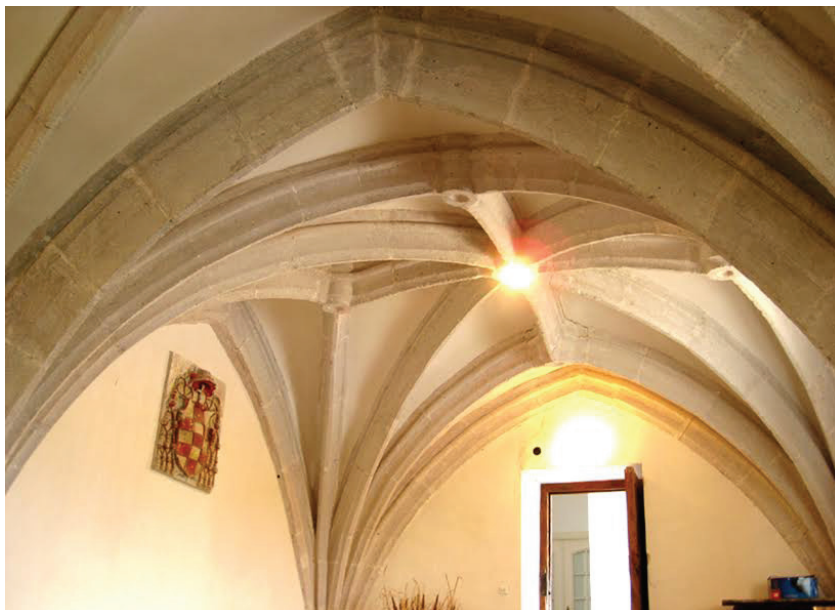
Fig. 4. La Aldehuela de Torrelaguna. Bóvedas de la capilla de la torre (fotografía de R. González Ramos).
