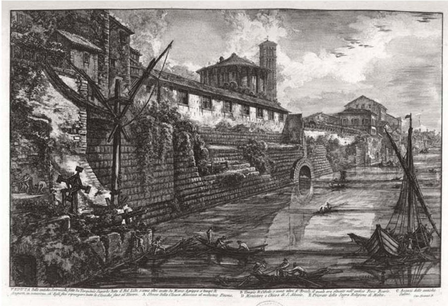
Fig. 8. Sostruzioni y Cloaca Máxima [BH GRL 2 (60)].
