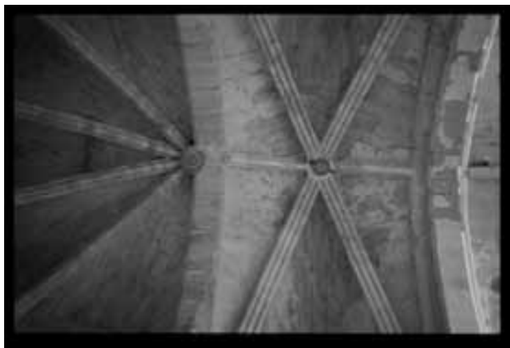
Fig. 4. Cubriciones abovedadas con nervadura en ligazón central del presbiterio y ábside de la iglesia abacial de Santa María de Piedra.
