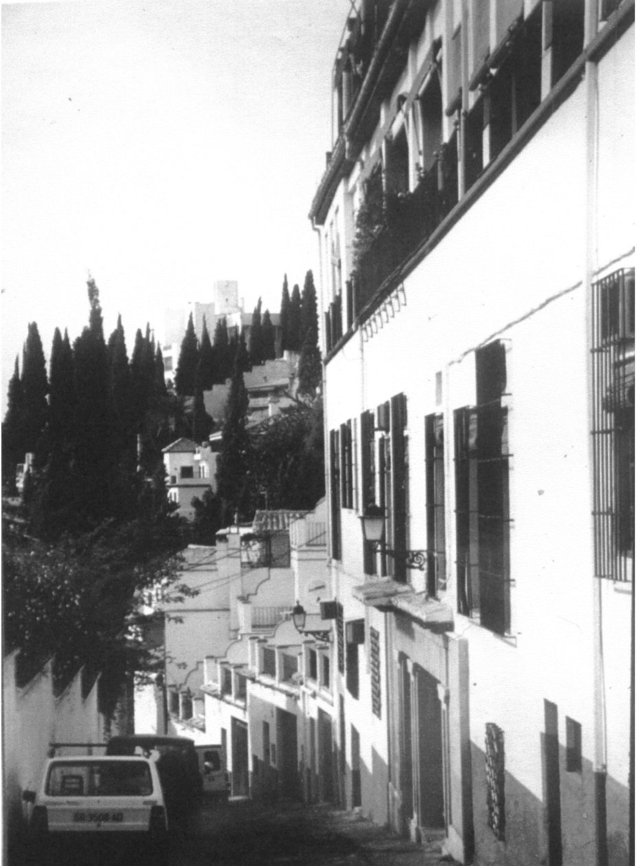
Foto 8.—La orientación a mediodía de la Antequeruela favorece la instalación de cármenes que se identifican, desde lejos, por la presencia de los tradicionales cipreses.
